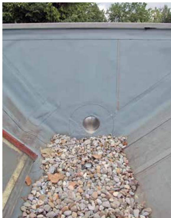
Beispiel für eine Notentwässerung durch die Attika
