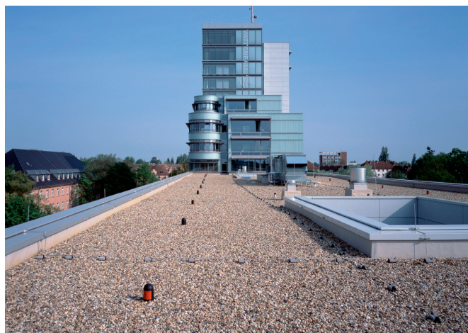
Kiesdach, Verlegung mit Auflast
