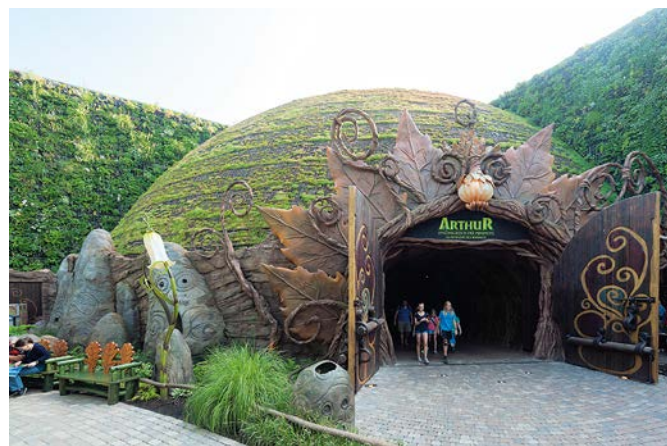
Bild 6. Gründachabdichtung mit wurzelfesten Kunststoffdachbahnen (Foto: DUD-Mitgliedsunternehmen Sika Deutschland GmbH)
