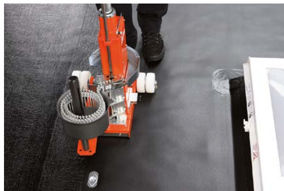
Bild 5. Wirtschaftliche mechanische Befestigung mit Setzautomat (Fotos 3 und 5: DUD Mitgliedsunternehmen Wolfin Bautechnik GmbH)
