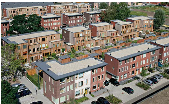
Bild 4. Flachdachabdichtung mit Kunststoff- und Elastomerbahnen (Fotos 1 und 4: DUD-Mitgliedsunternehmen CARLISLE® Construction Materials GmbH)
