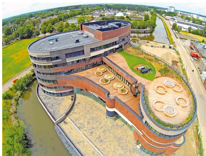
Bild 1. Gründachabdichtung mit wurzelfesten Kunststoff- und Elastomerbahnen
