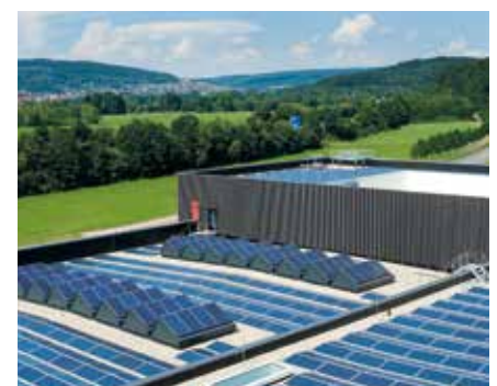
Neu in DIN 18531 – genutzte Dächer mit Photovoltaik
