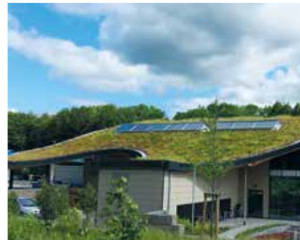
Extensive Begrünung – ungenutzt nach DIN 18531
