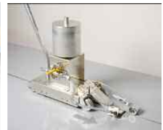
Abb. 4: Befestigung der Wandanschlüsse mit einem Quellweißautomaten
