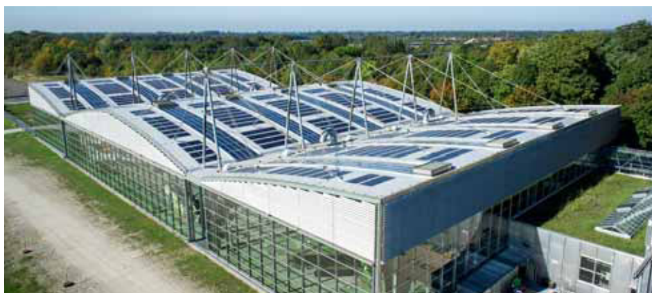
Neu in DIN 18531 – genutzte Dächer mit Photovoltaik.
