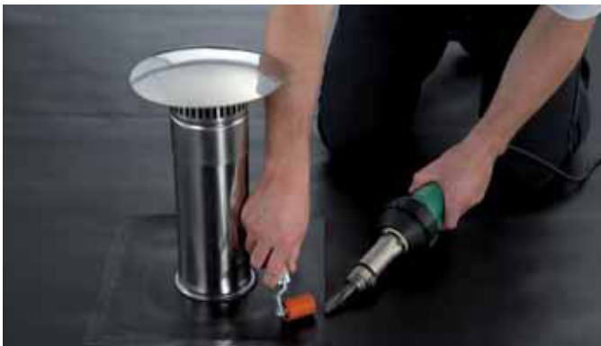
Detailanschluss: Zuverlässige Nahtfügung mit handlichem Heißluftschweißgerät.
