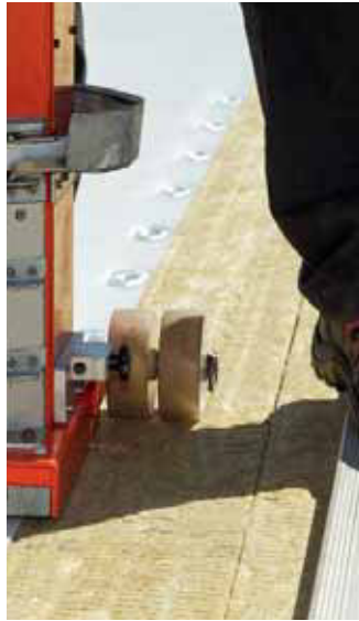
Befestigung der Dachabdichtung mit der Setzmaschine.
