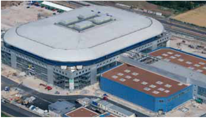
Projektbeispiel SAP Arena: Dauerhafte Funktionalität und Dichtigkeit sind die entscheidenden Faktoren für die Flachdachabdichtung.
