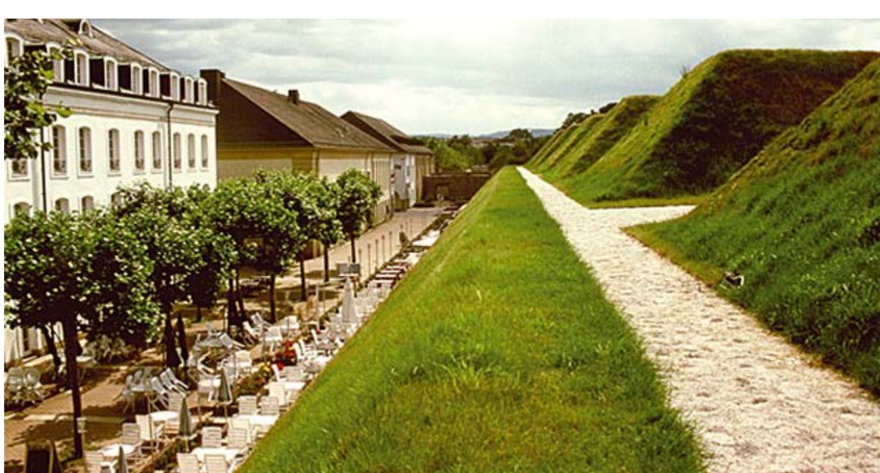
Gründächer kommen nicht nur auf dem Flachdach vor. Bei der Sanierung der Kasematten in Saarlouis kamen Kunststoffbahnen als Abdichtung unter der Begrünung zum Einsatz (Foto: DUD/Wolfin)
