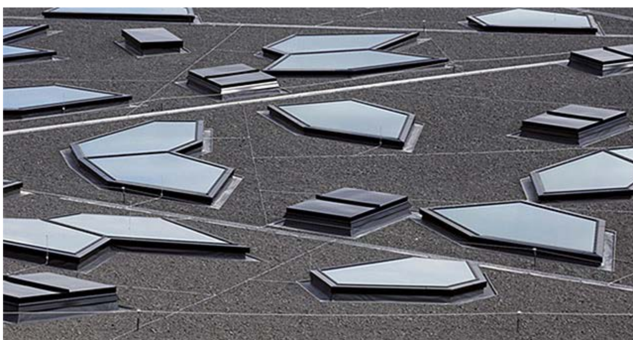
Das Dach als fünfte Fassade: Dachgestaltung mit modernen Kunststoffbahnen (Foto: DUD/Sika)
