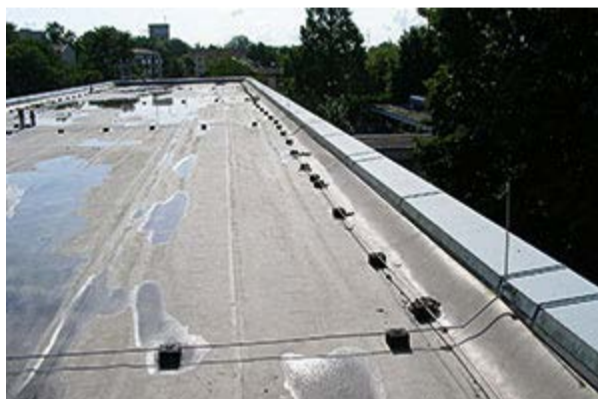
Bildquelle Sika: "Das Dach der Dorschbergschule in Würth, eine Bitumensanierung, ist bereits seit 1990 beständig dicht."
