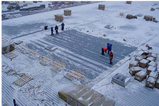
Abschnittsweise Schneeräumung zur Erstellung des Dach-Schichtenaufbaus
