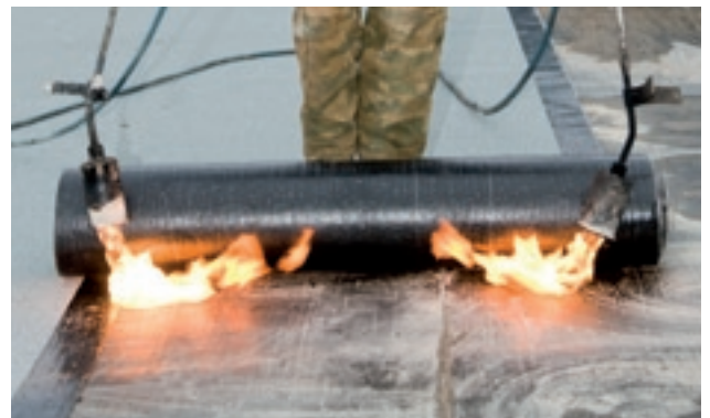
Verarbeitung von Bitumenbahnen mit offener Flamme
